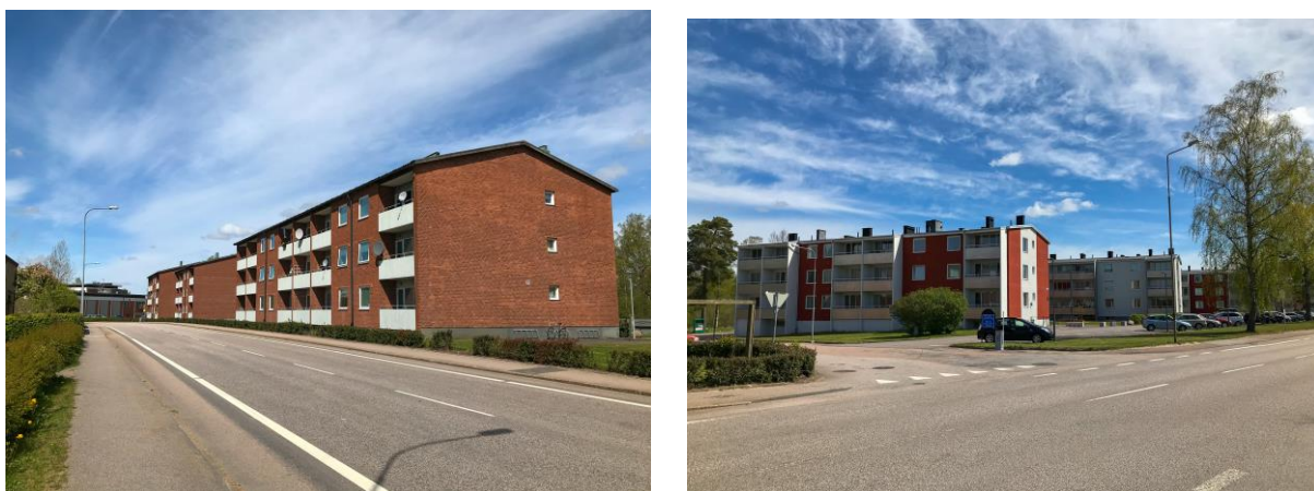
Figur 7 och 8. Bostadsbebyggelse längs med Norra Industrigatan, väster (t.v.) respektive öster (t.h.) om Porsagränd.
