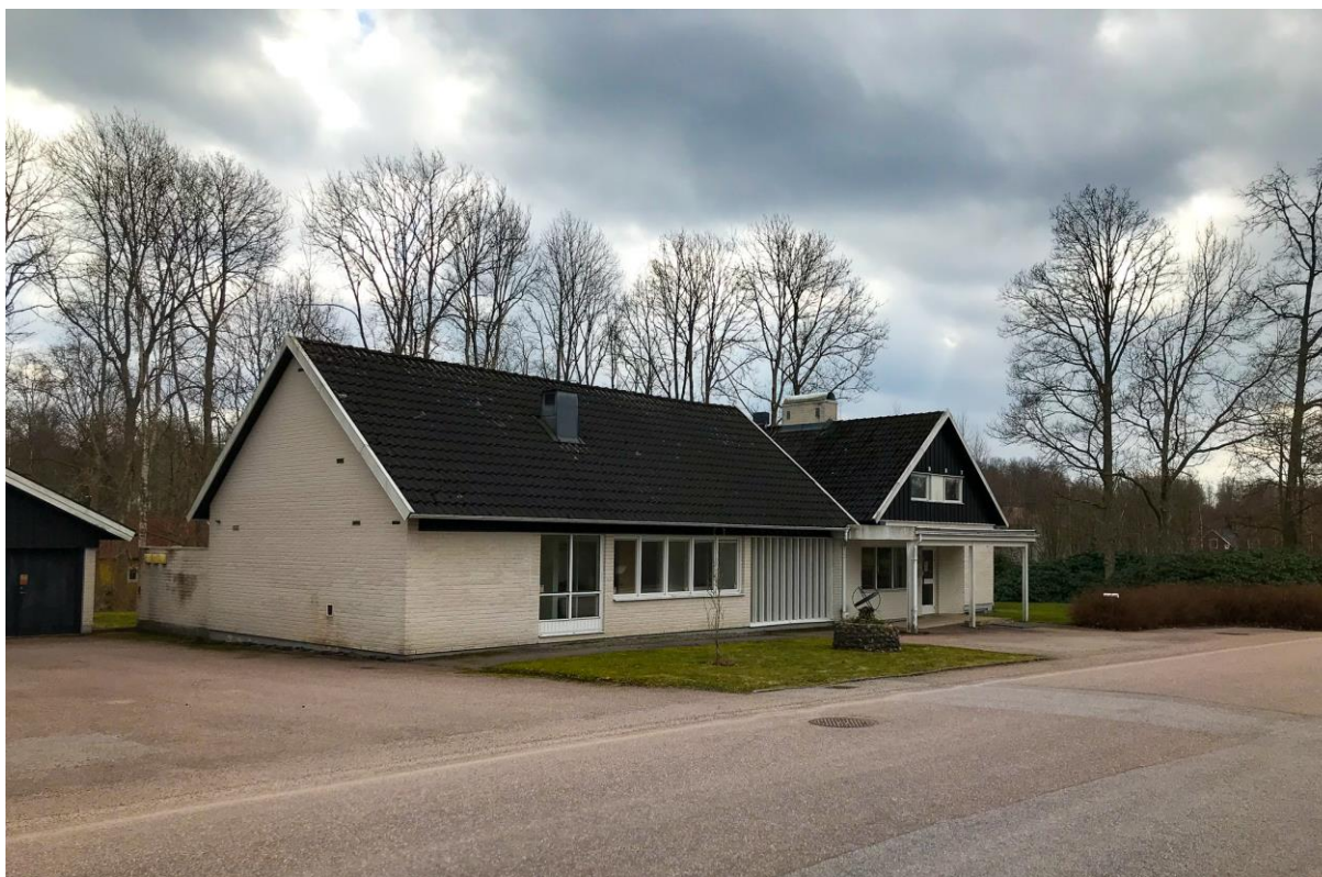
Bild 7 Tidigare prästbostad och administrationsbyggnad på Västra Hylte 3:13. Byggnaden står nu tom.
