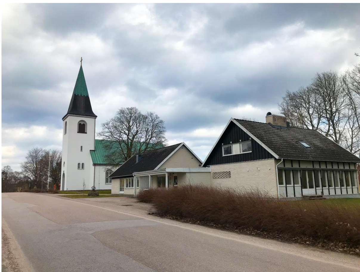
Bild 4 Befintlig byggnad på fastigheten Västra Hylte 3:13 med kyrkan i bakgrunden.
