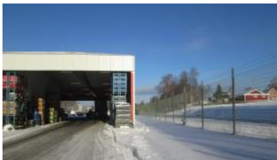
Foto 7. Skärmtak utmed den östra sidan av byggnaden, där lastning och lossning sker.
