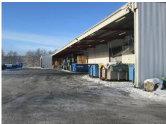
Foto 5. Skrotcontainrar i byggnadens sydöstra hörn. Åtgärder kommer att genomföras under våren 2016 för att komma till rätta med bullernivån vid angränsande fastighet i sydöst.
