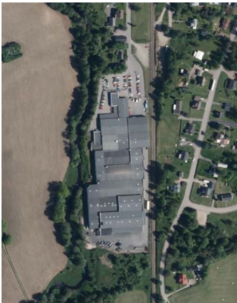
Foto 9: Österån med angränsande vegetation väster om Gnotecs byggnad.
