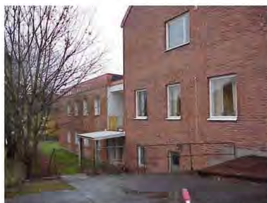
Hyreshus sett från nordost (Unnaryd 2:87)
