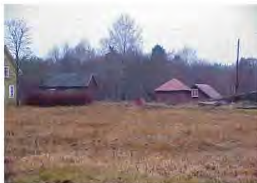
Ekonomibygnader sett från nordost
