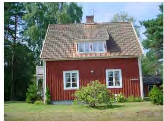
Nordvalla sett från sydost
