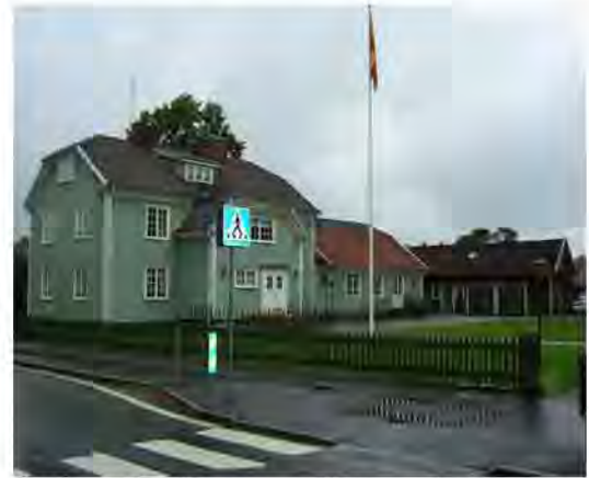
Del av uthuslängan sett från nordost
