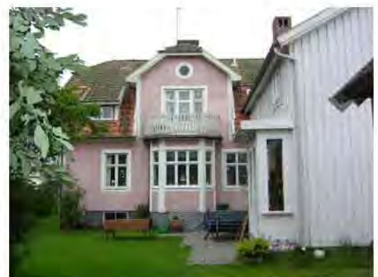
Solliden sett från sydost
