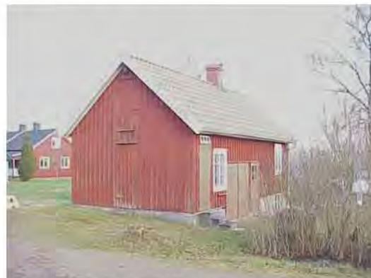
Mariebergs uthus sett från sydväst
