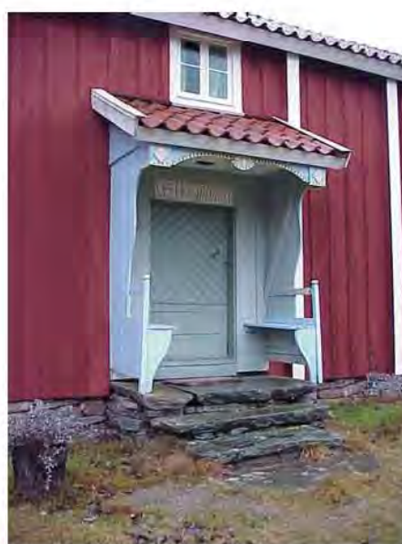
Sävsåsstugans entré sett från sydväst
