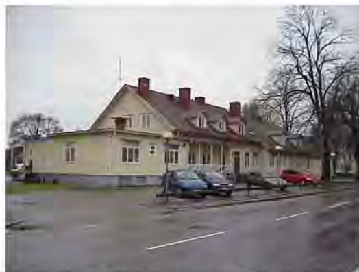
Huvudbyggnaden sett från nordväst
