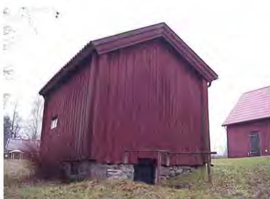
Loftboden sett från sydost
