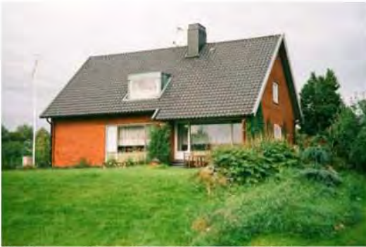
Villa sett från söder (Unnaryd 14:1)
