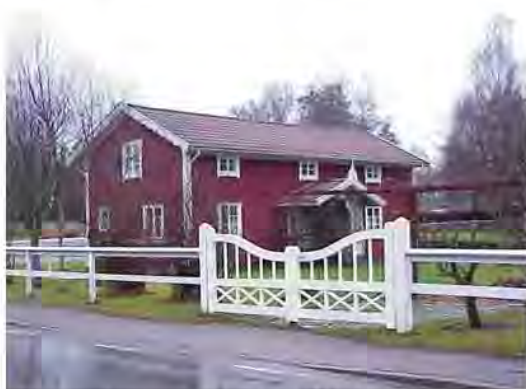
Timmerbyggnad sett från nordost
