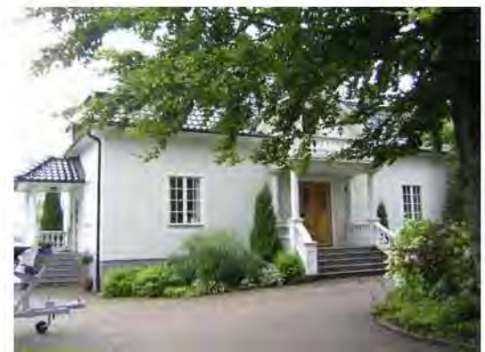
Fallet sett från nordost
