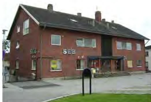
Hyreshus sett från nordost (Unnaryd 2:49)
