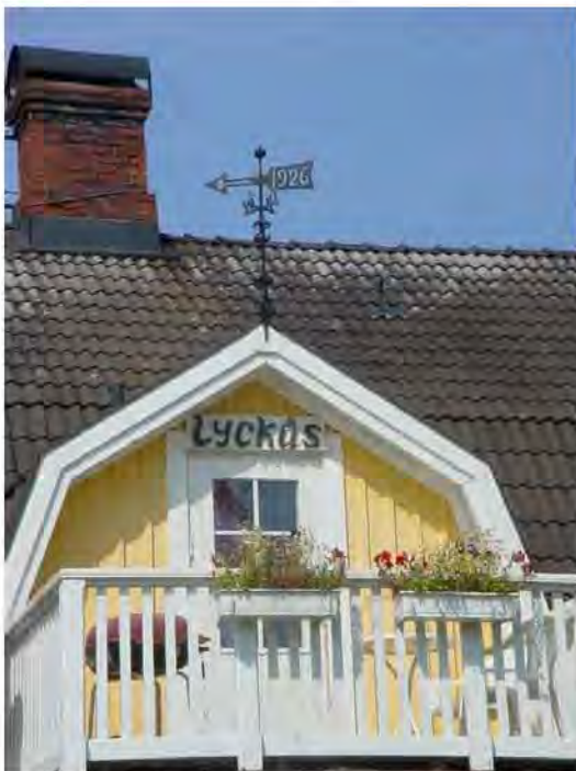
Frontespis sett från sydost
