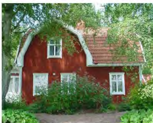
Asphyddan sett från sydost
