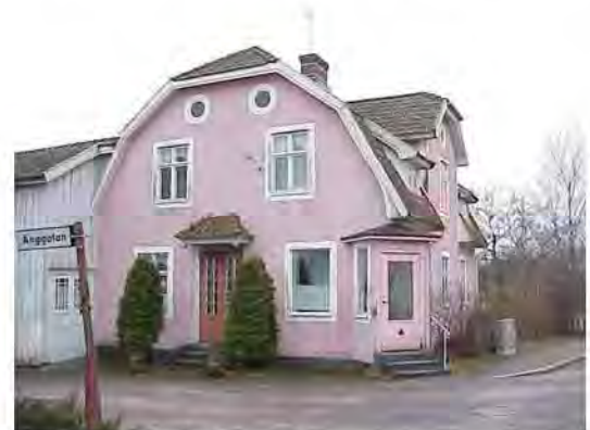
Solliden sett från nordost
