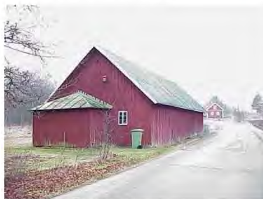
Ladugård sett från sydost
