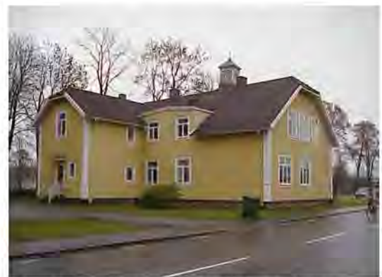
Gamla läkarbostaden sett från nordväst
