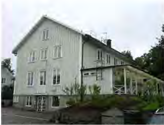
Gamla kommunalhuset sett från sydost
