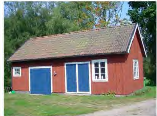
Uthus sett från söder
