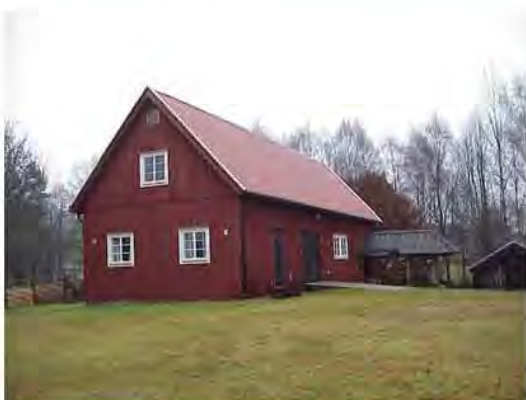
Ekonomibyggnad sett från väster
