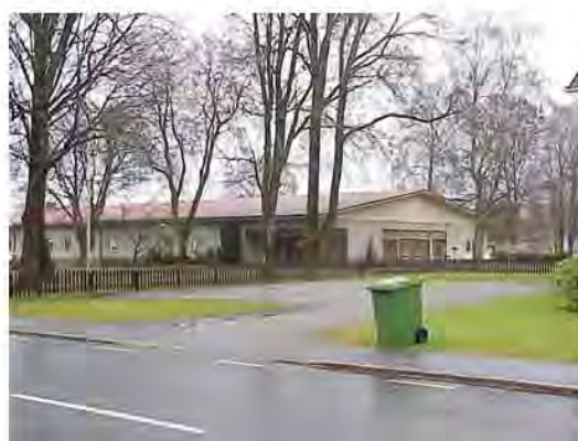
Del av tillbyggnad sett från sydväst
