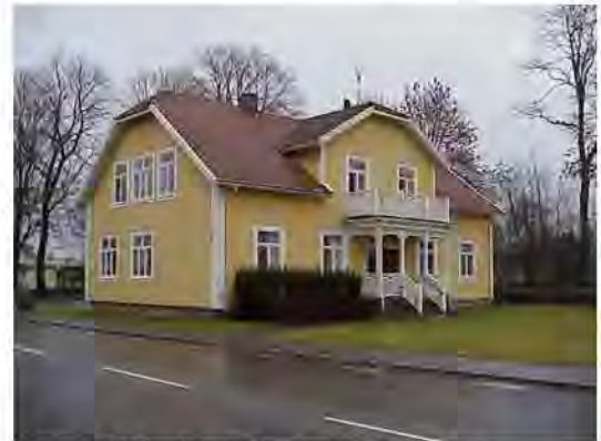
Gamla läkarbostaden sett från sydväst
