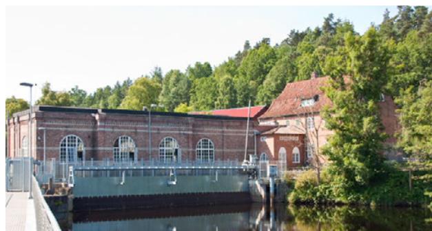
Kraftverket ägs idag av Varbergs Energi.
