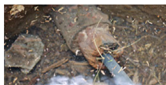
Ledningsstocken vid källan
