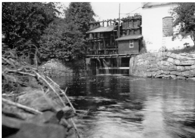
Turbinsumpen och avloppet vid träsliperiet, som syns till höger i bilden, tagen 1933.
