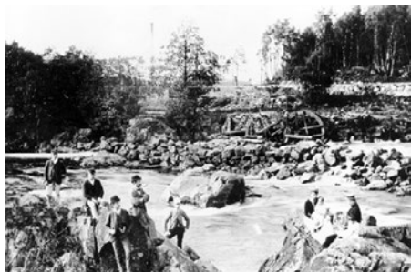
Resterna av kvarnen 1890- talet. Höljen nedanför till vänster.
