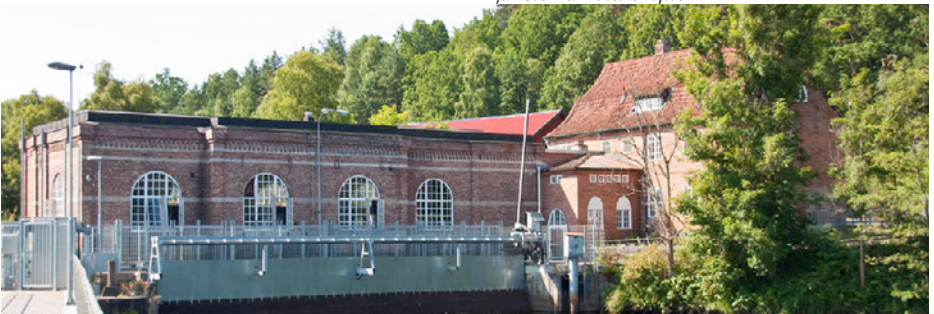
Kraftverket ägs idag av Varbergs Energi. Foto: Göran Fritzton
