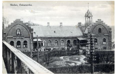
Här har den norra flygeln byggts till, några år in på 1900-talet
