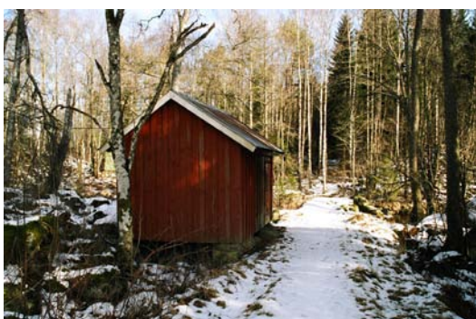
Förråd vid Kilen sett fr. sydväst
