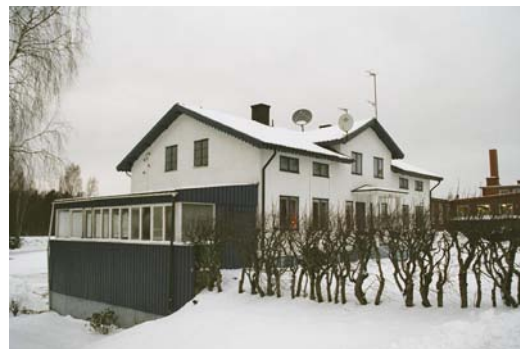
Manhusbyggnad sett fr. sydost
