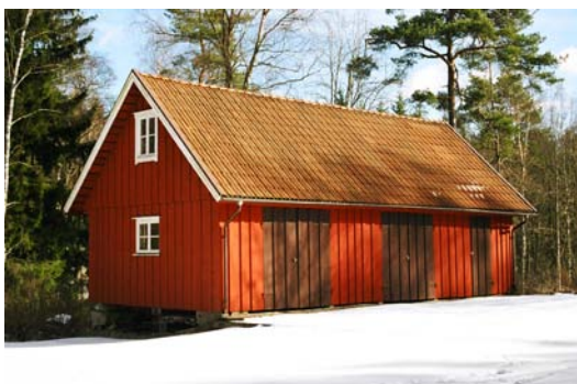
Ladugård sett fr. väster
