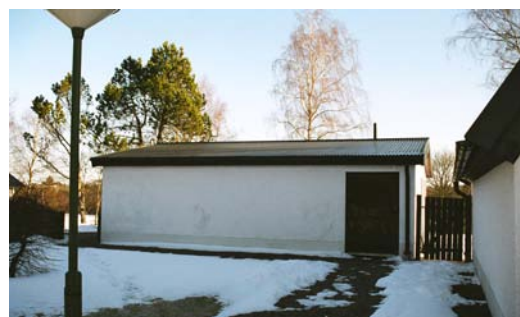
Förrådsbyggnad sett fr. sydväst
