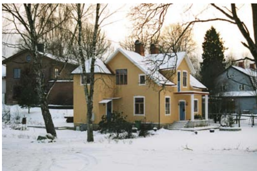
Villa sett fr. norr
