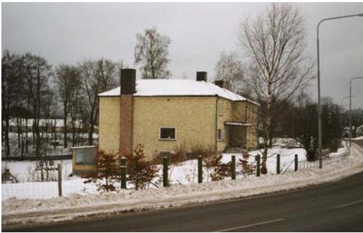
Villa sett fr. norr
