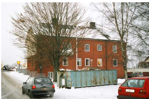
Byggnadens baksida sett fr. söder
