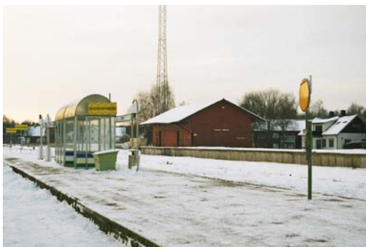
Godsmagasin sett fr. sydost
