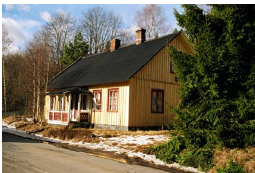
Manbyggnad sett fr. sydost
