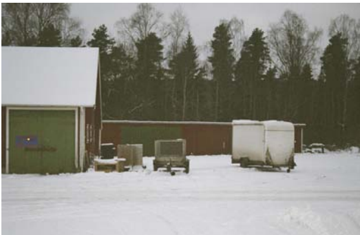
Ekonomibyggnader sett från öster
