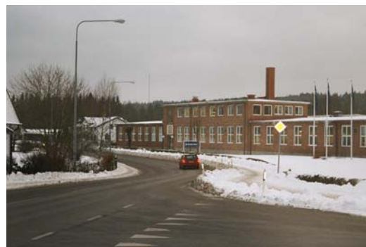
Industribyggnad sett fr. nordost
