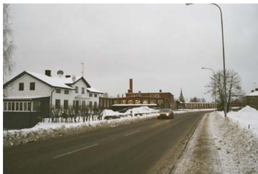
Manhusbyggnad sett fr. söder
