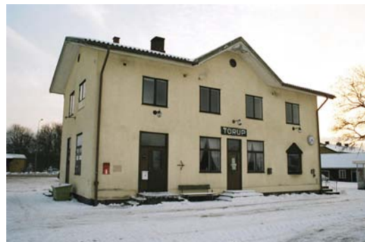
Järnvägsstationen sett fr. sydost
