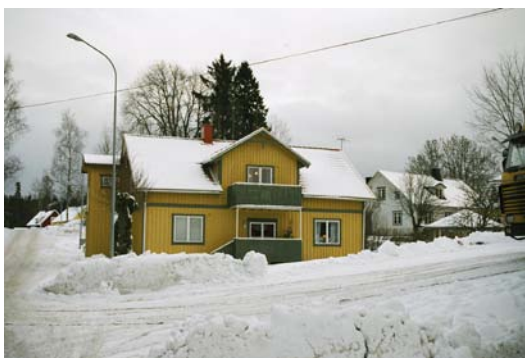
Trävilla sett fr. norr
